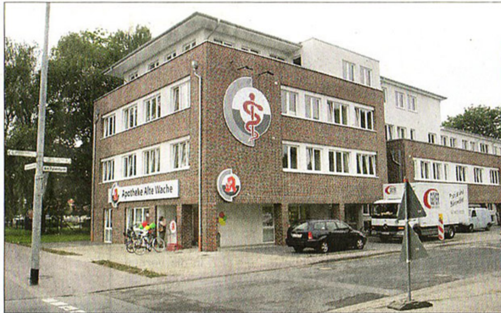
In nur einem dreiviertel Jahr wurde das neue Gesundheitszentrum „Alte Wache“ an der Cloppenburger Straße 296 fertiggestellt.
